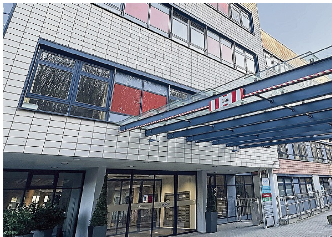
Außenansicht des Krankenhauses Eichhof in Lauterbach. Die Klinik treibt die Digitalisierung voran und schafft damit die Grundlage für künftige Anwendungen künstlicher Intelligenz in Diagnostik und Therapie.
