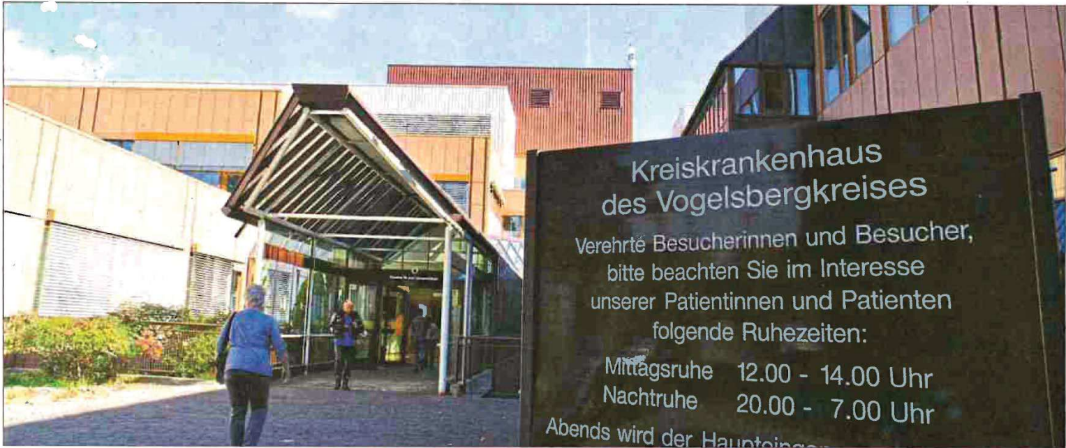
Mit den Bauarbeiten am Krankenhaus in Alsfeld soll es im Januar losgehen. Zunächst werden Dach und Fassaden saniert. (Foto: Archiv)
